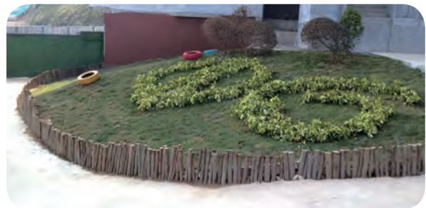
Garden construction site 花園式施工工地
